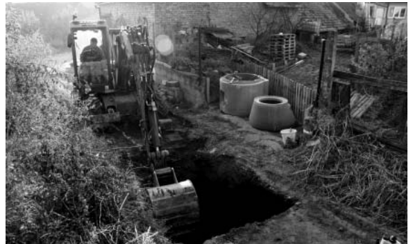
Na Pajerce se začíná s výkopovými pracemi pro budoucí kanalizační potrubí.
