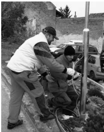
Na Hlavní ulici byly nainstalovány nové lampy veřejného osvětlení.
